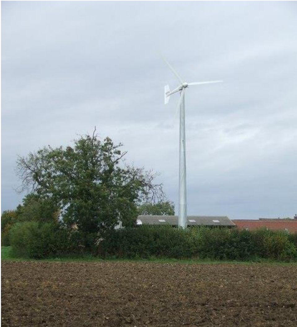
Figuur 9: Voorbeeld van een HAT met een grondopstelling met zelfdragende mast
