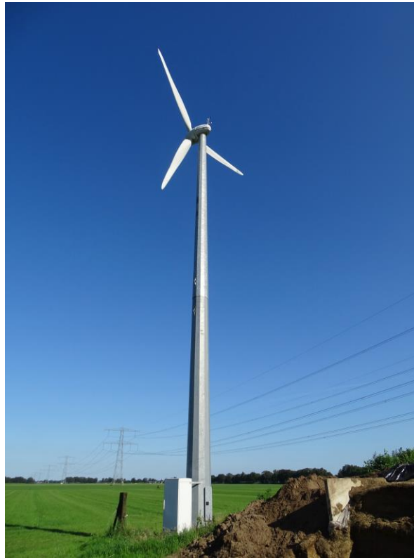
Figuur 4; de BestWatt windturbine met een as-hoogte van 20 meter
